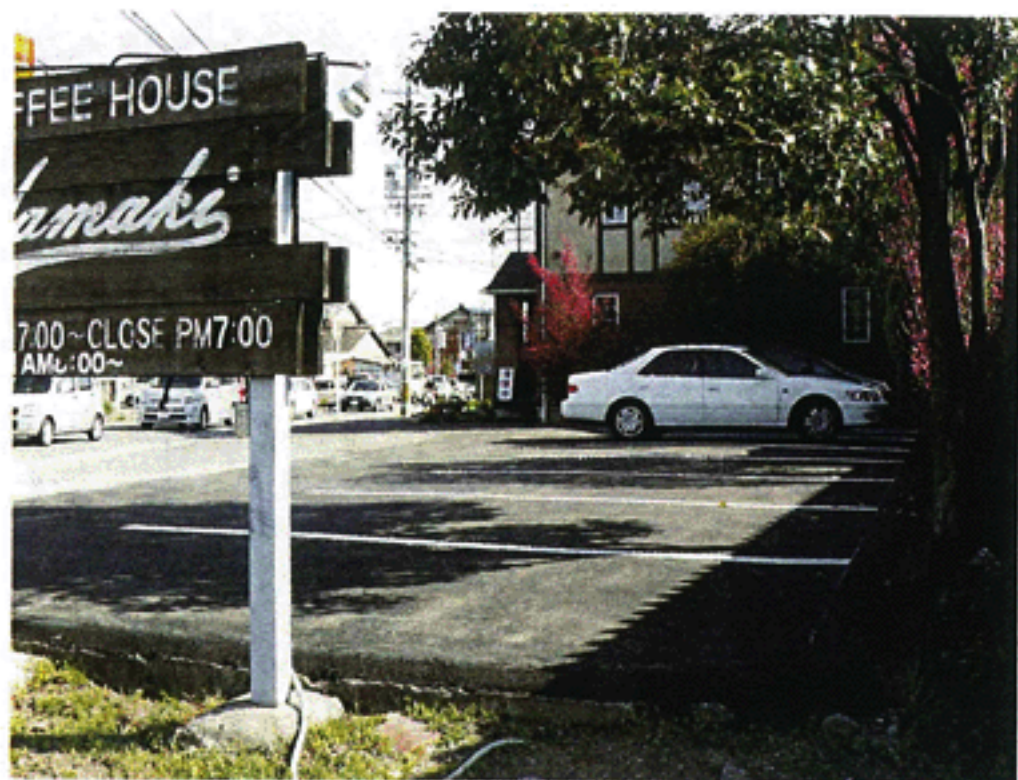
竣工したばかりのヤマキの駐車場。地中に残る既存構造物による凹凸をオーバーレイ舗装で補修した。解体・撤去を伴う大掛かりな工事を覚悟していたオーナーの山口さんは、格安な価格に喜んだ
